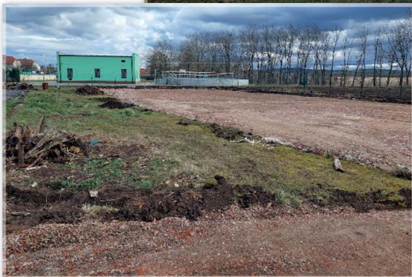
Nově vybudovaná zpevněná plocha vedle kompostárny
