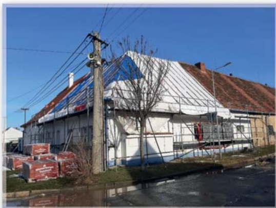
oprava střechy bývalého statku
