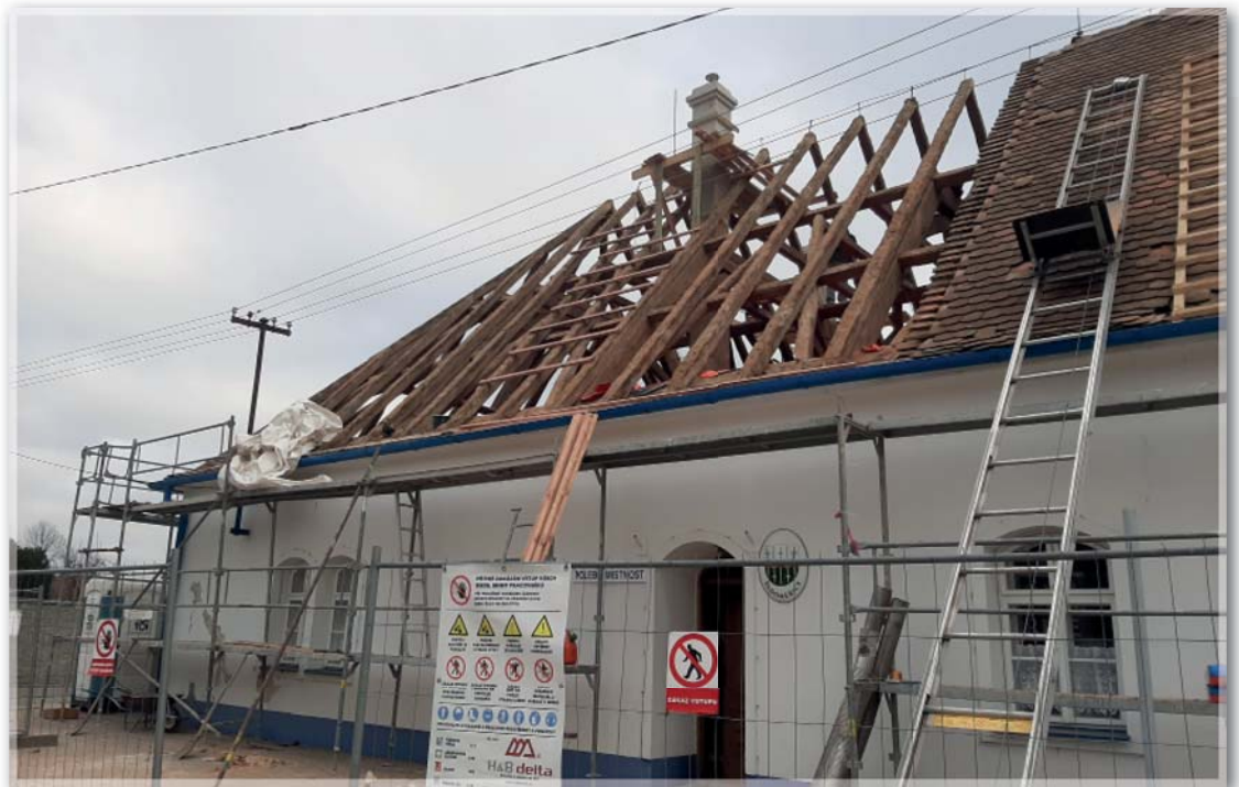
oprava střechy bývalého statku
