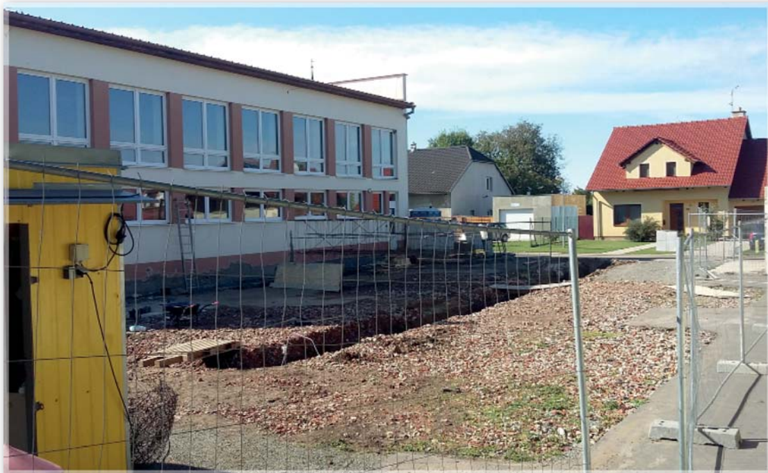
stavba přístavby tělocvičny se společenským sálem
