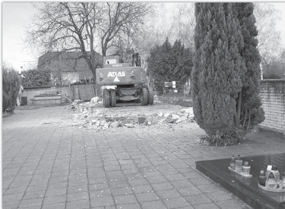
demolice smuteční síně
